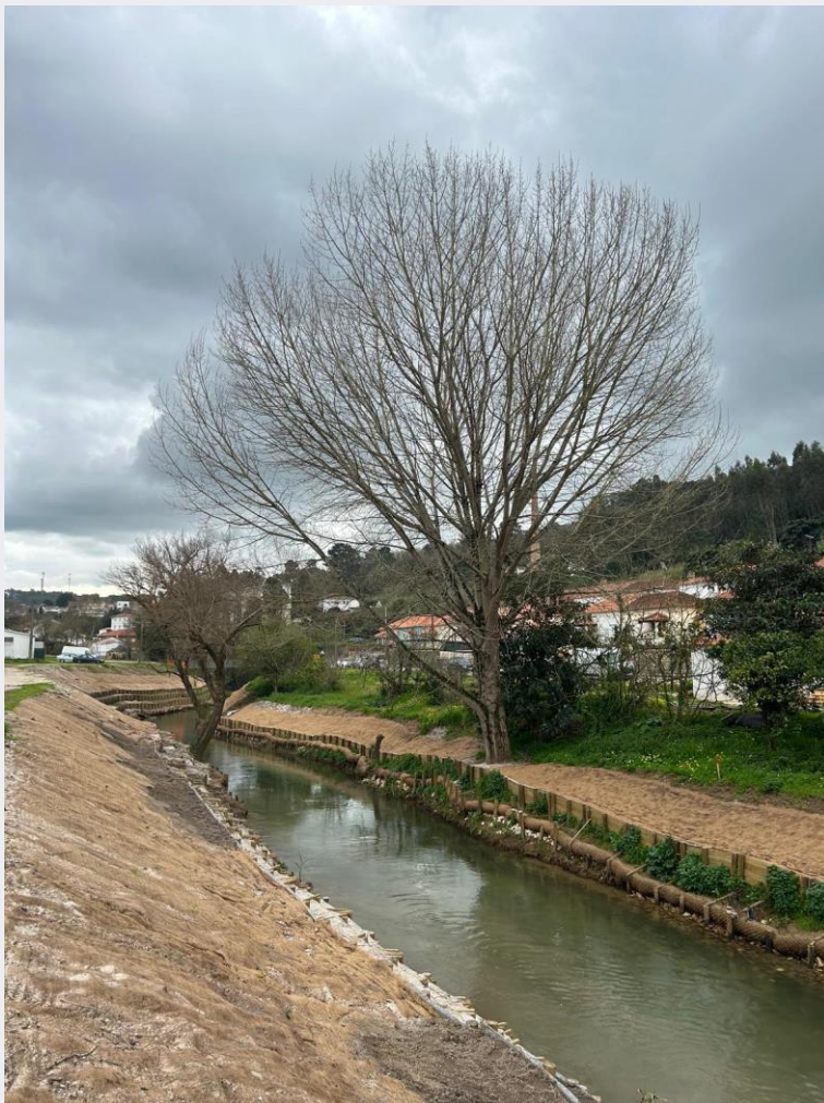
MUNICÍPIO DE ALCOBAÇA - Reabilitação e Valorização da Rede Hidrográfica dos Rios Alcoa e Baça
